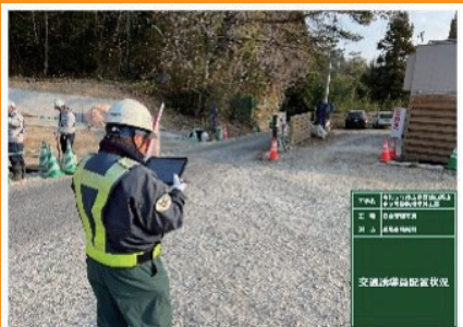
現場で：出入口誘導員
